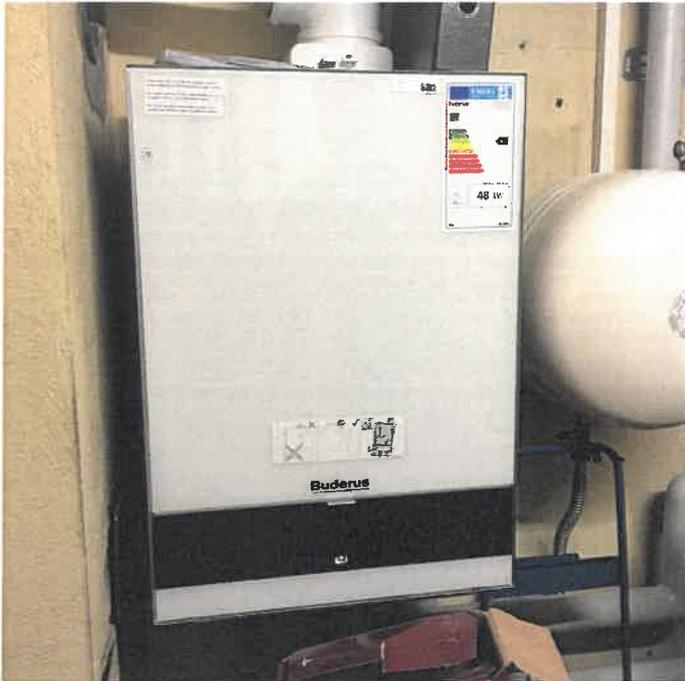
Abbildung 10: Neuer 48 kW-Brennwert-Kessel als Ersatz für vorigen 23 kW-Brennwert-Kessel
